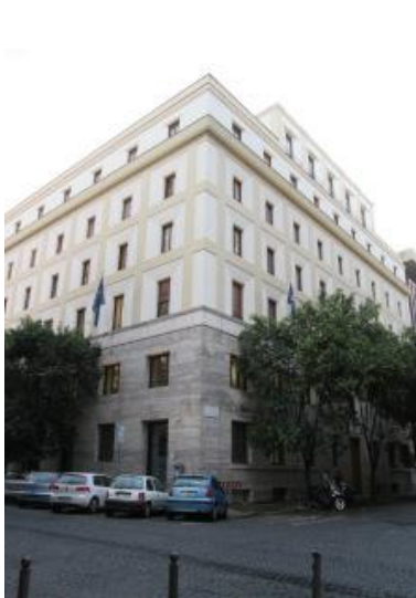
Außenansicht Via Valadier 37
